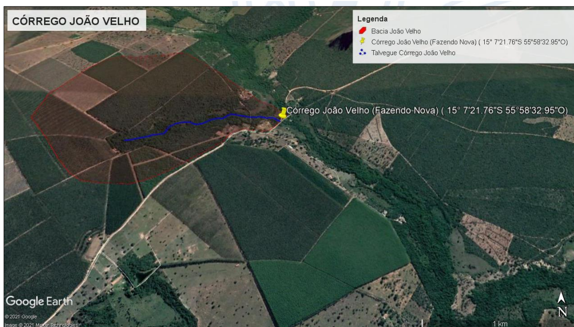
Figura 24 – Córrego João Velho, Chapada dos Guimarães/MT
