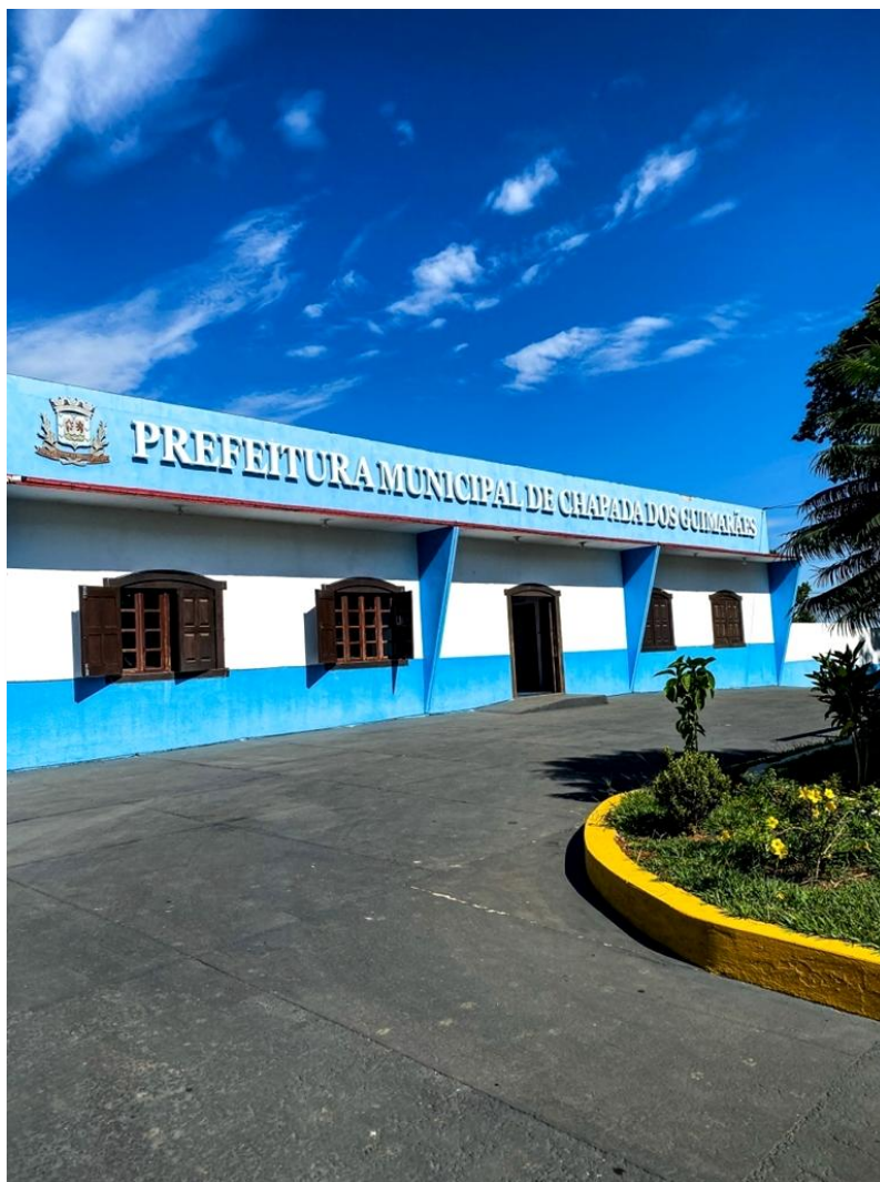
Figura 6 - Fachada frontal da Prefeitura Municipal de Chapada dos Guimarães. Fonte: Trabalho de campo, novembro e dezembro de 2023.
