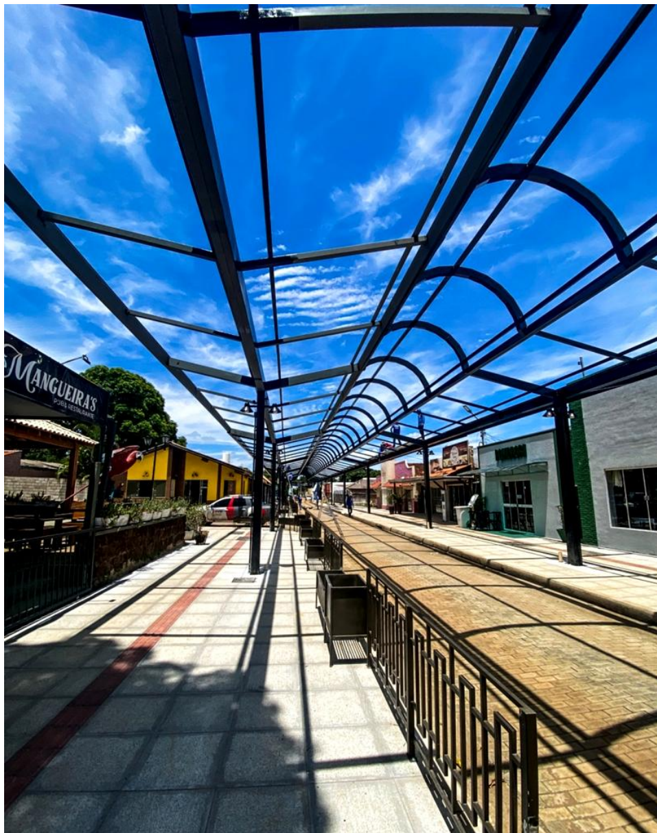
Figura 13 - Obras da rua coberta no Centro Histórico em fase de finalização. Fonte: Trabalho de campo, novembro e dezembro de 2023.
