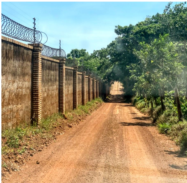
Figura 28 - Área lateral ao condomínio Serras Azuis. Fonte: Trabalho de campo, novembro e dezembro de 2023.
