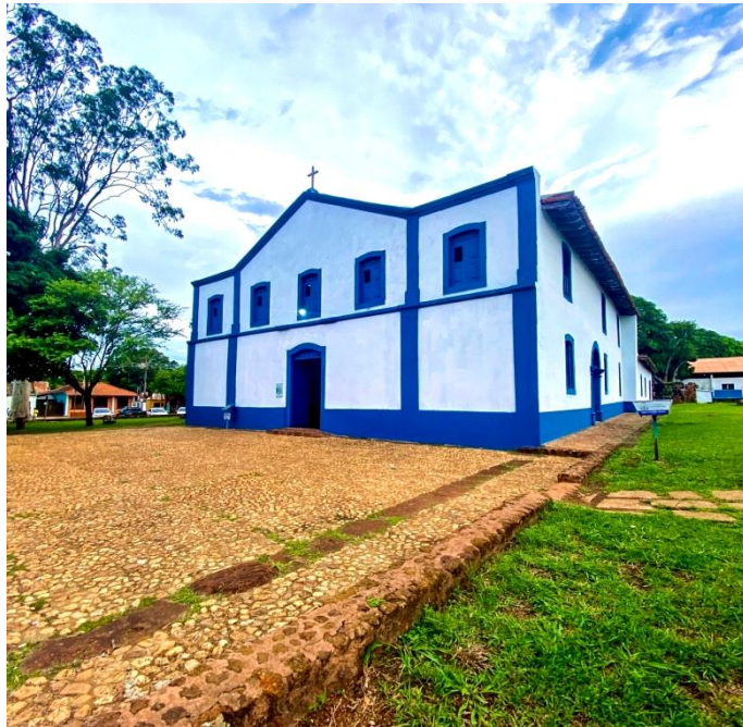
Figura 9 - Vista frontal da Igreja Matriz Santuário de Sant'Ana com o piso, calçada e obras viárias do entorno reformadas. Fonte: Trabalho de campo, novembro e dezembro de 2023.
