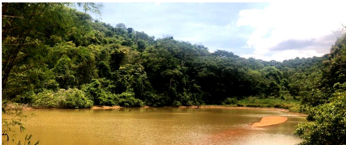
Figura 33 - Lago formado por barragem existente na antiga captação de água bruta do SAAE - Sistema Autônomo de Água e Esgoto de Chapada dos Guimarães. Fonte: Trabalho de campo, novembro e dezembro de 2023.
